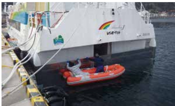
【船体点検作業】
