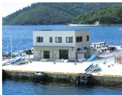
別府港の突端に位置する別府整備工場 平成 25 年 3 月竣工
