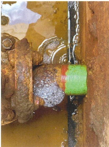
配管から漏えいしている状態
