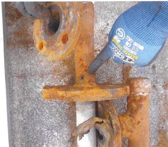
腐食によるピンホールが発生した状態
