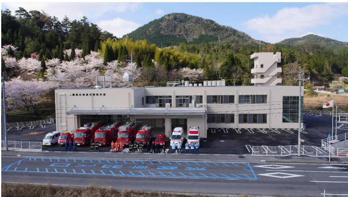
(隠岐広域連合消防本部庁舎)
